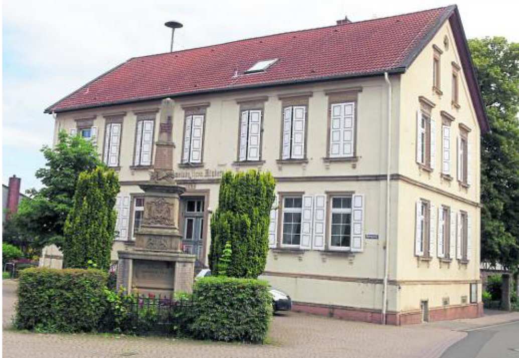
Das Dorfgemeinschaftshaus wird barrierefrei, auch der Brandschutz wird verbessert. Archivfoto: pa/Schmitz
