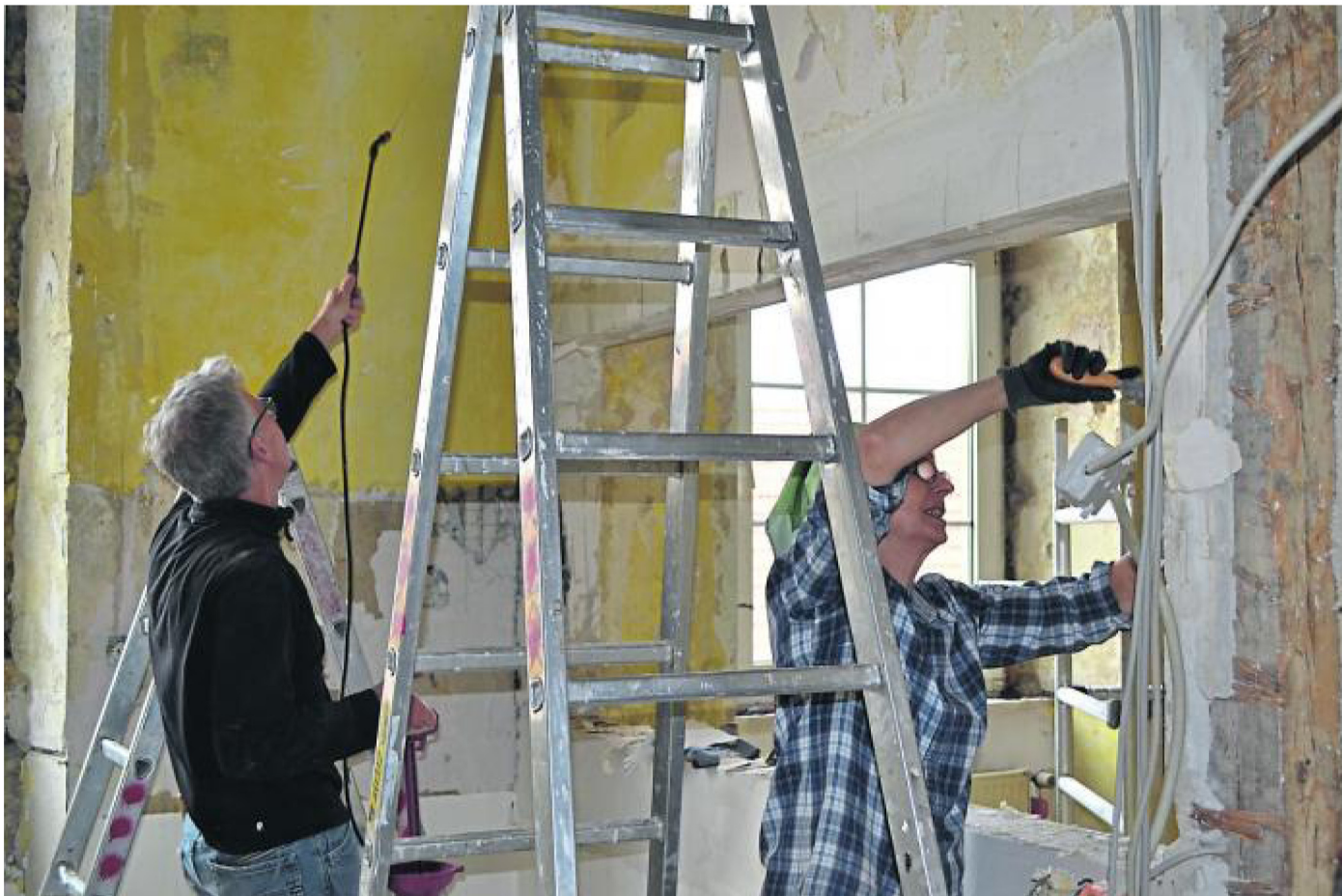
Unentgeltlich, ehrenamtlich: Entkernungsarbeiten am Dorfgemeinschaftshaus in Siefersheim.
